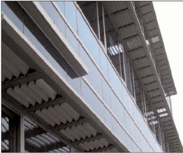
Parte superior: Exterior del sistema "Sun Blade"
