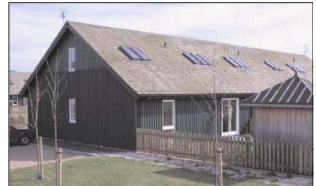
Viviendas sociales descritas por Fionn Stevenson
